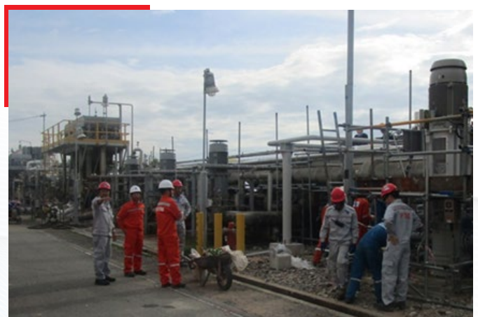
Kiểm tra Dự án NPK và NH3 Phú Mỹ
